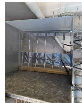
Bild 7: Pendeleinflug verschlossen - finaler Verschluss durch Eigentümer erforderlich
