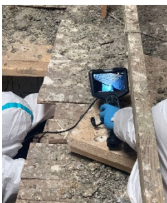
Bild 6: Einsatz Endoskopkamera zur Inspektion von Nestern in Hohlräumen
